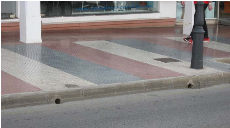
Salida de bajantes de terrazas a calzada
