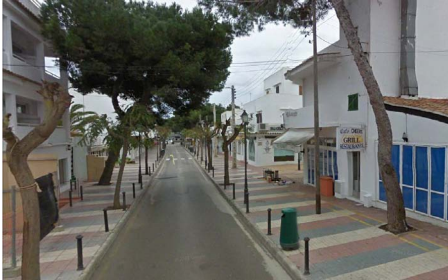
Postes y línea eléctrica aérea
